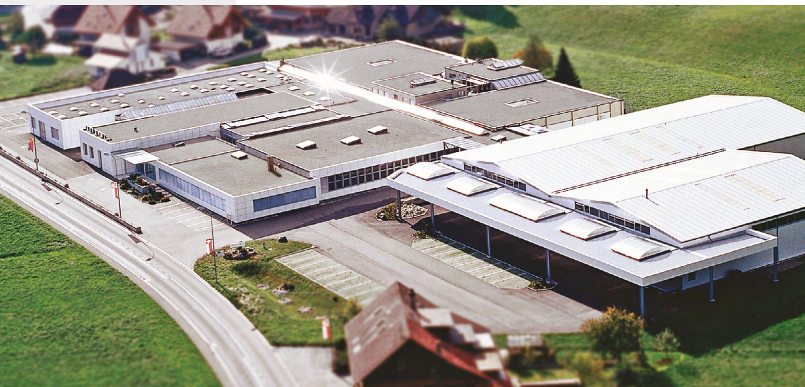
Siège principal Frama AG, Lauperswil, avec développement et production
